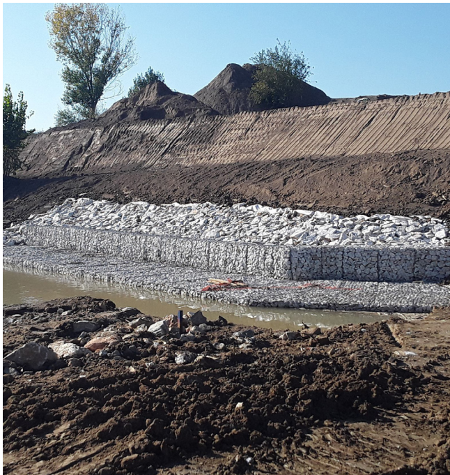
Αποκατάσταση ρεμάτων με την κατασκευή ζαρζανετιών
