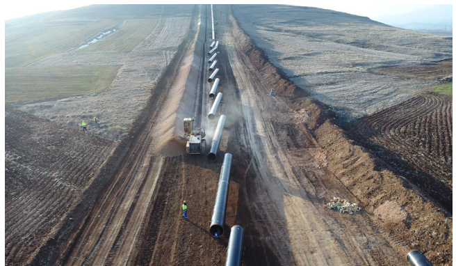
Διάνοιξη χάνδακα με τη χρήση trencher
