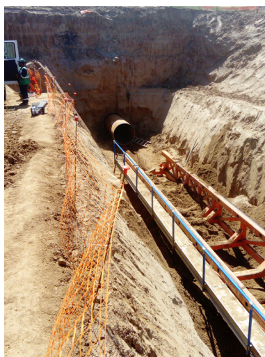
Διάτρηση μικρού μήκους σε εξέλιξη
