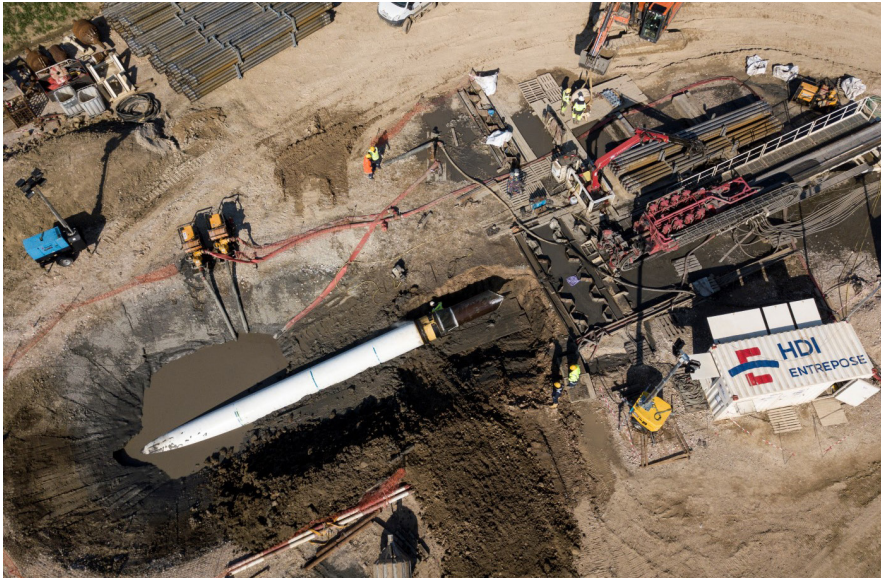
Διαδικασία διάτρησης εδάφους στον Αξιό ποταμό
