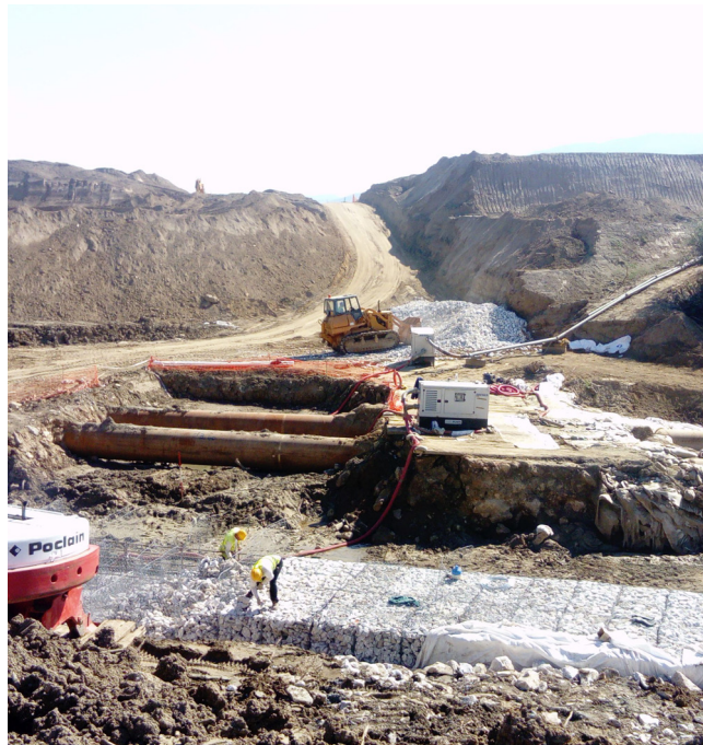
Αποκατάσταση ρεμάτων με την κατασκευή ζαρζανετιών
