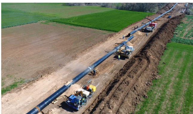
Εργασίες αυτόματης συγκόλλησης
