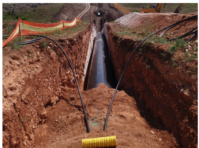
Επίκωση αγωγού - δίοδοι πολυαιθυλενίου Ø50 - προειδοποιητικό πλέγμα
