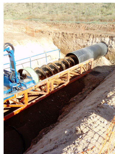
Θυσιαζόμενος Αγωγός - Διάνοιξη μικροσφήραγας
