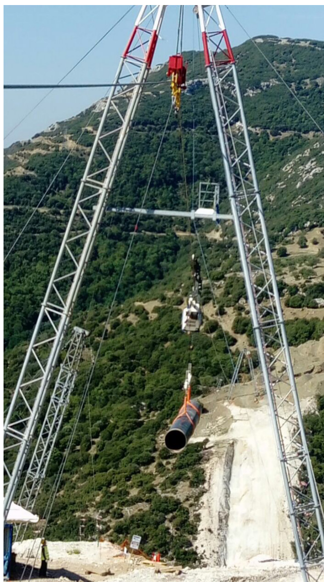
Μεταφορά τμημάτων του αγωγού με τελεφερίκ, περιοχή Καβάλας
