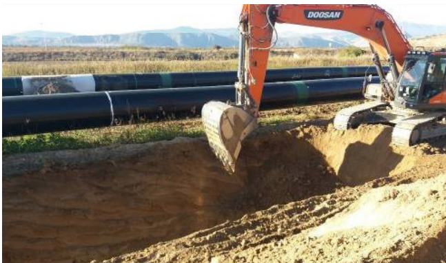
Διάνοιξη χάνδακα με τη χρήση εκσκαφέα
