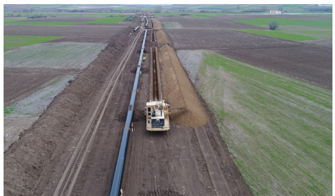
Διάνοιξη χάνδακα με τη χρήση trencher
