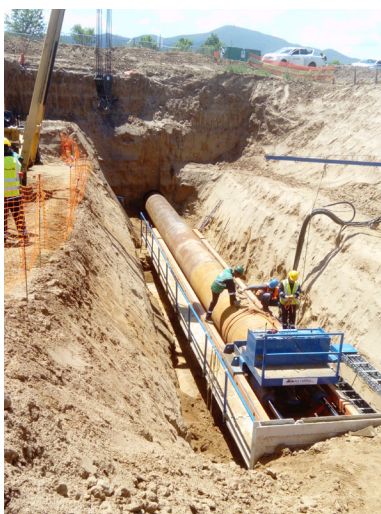
Διάτρηση μικρού μήκους σε εξέλιξη
