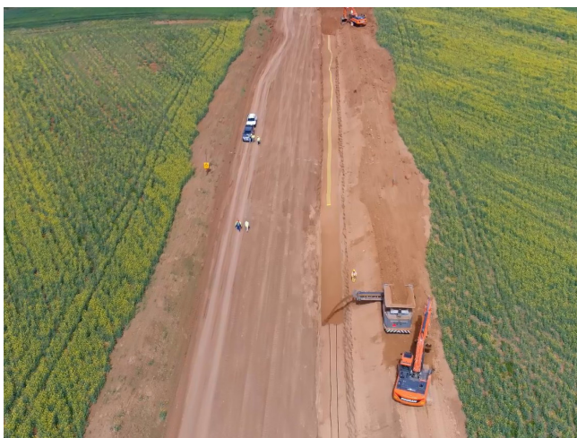
Ολοκλήρωση επίκωσης με διαβαθμισμένο υλικό
