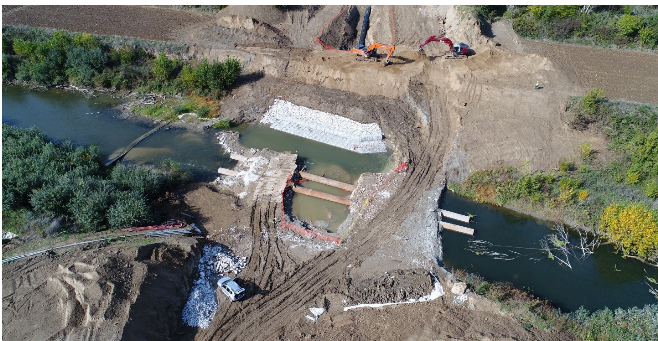
Αποκατάσταση με ζαρζανέτια σε υδάτινο πέρασμα
