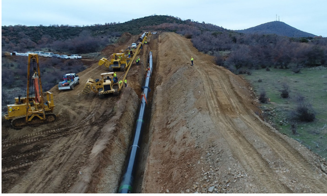
Καταβιβασμός του αγωγού
