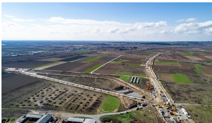
Προετοιμασία για την οριζόντια διάτρηση HDD στον Αξιό ποταμό, μήκους 1.800m
