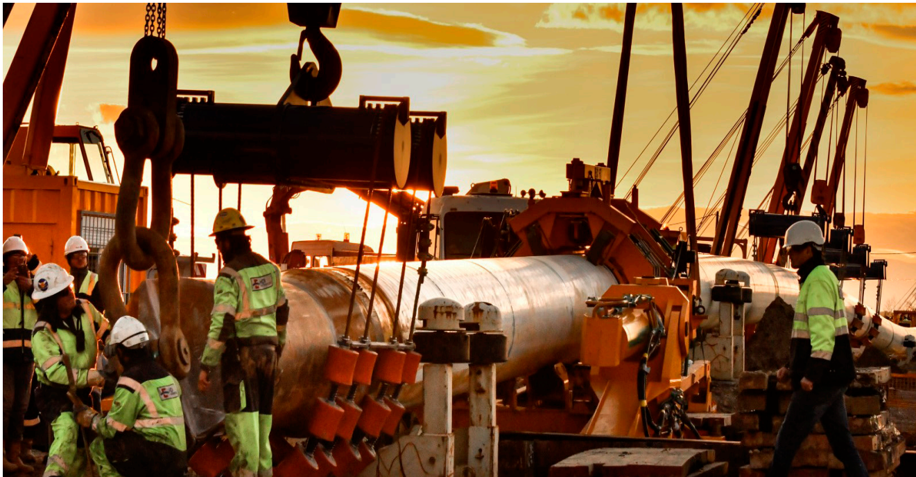
Τελικό στάδιο προετοιμασίας έλξης του προς εγκατάσταση αγωγού
