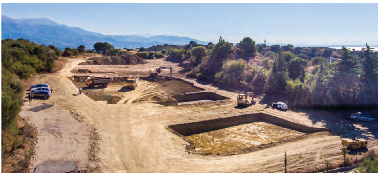
Εργασίες ανέγερσης του Υποσταθμού 20/150kV
