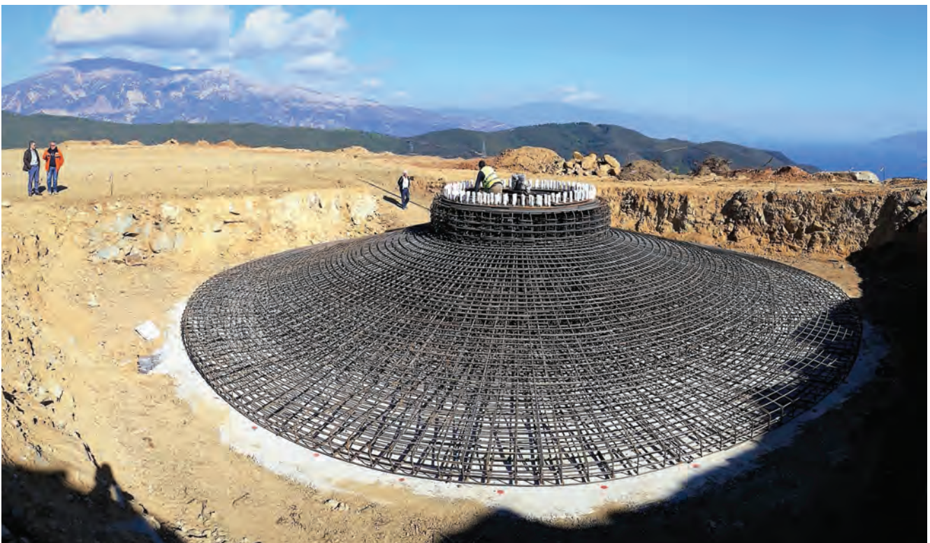
Θεμέλιο Α/Γ RI-02 με εγκατεστημένο anchor cage (κέντρο), γείωση και σπλισμό
